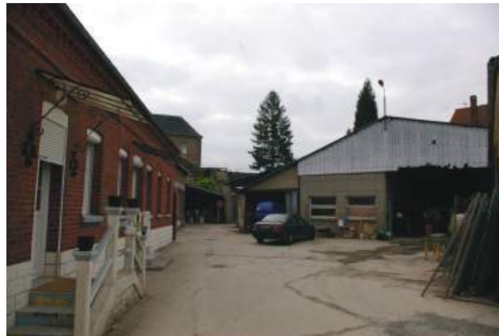
vue de la cour intérieure
