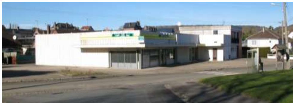
Ancienne supérette : projet de maison des services dont le permis de construire a été déposé en juillet 2017. Livraison des locaux en 2018.
