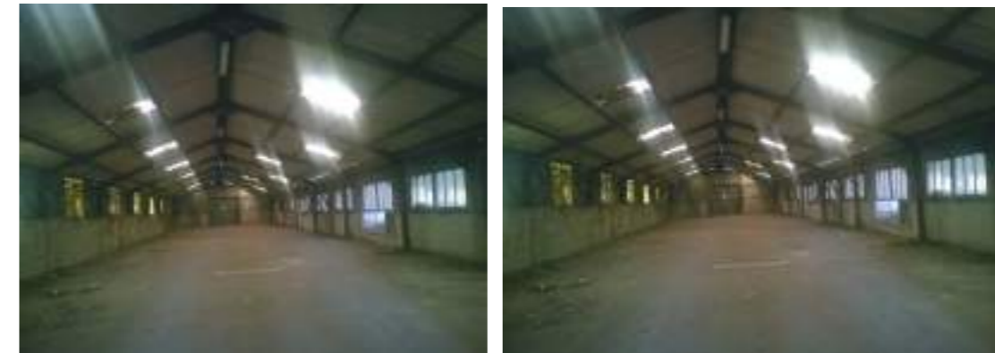
Charpente du bâtiment 3
