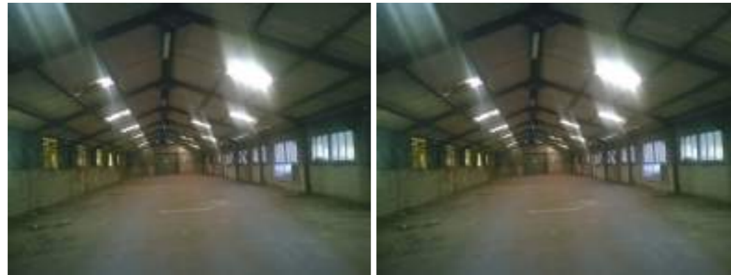
Hall 1 - Charpente Métallique
