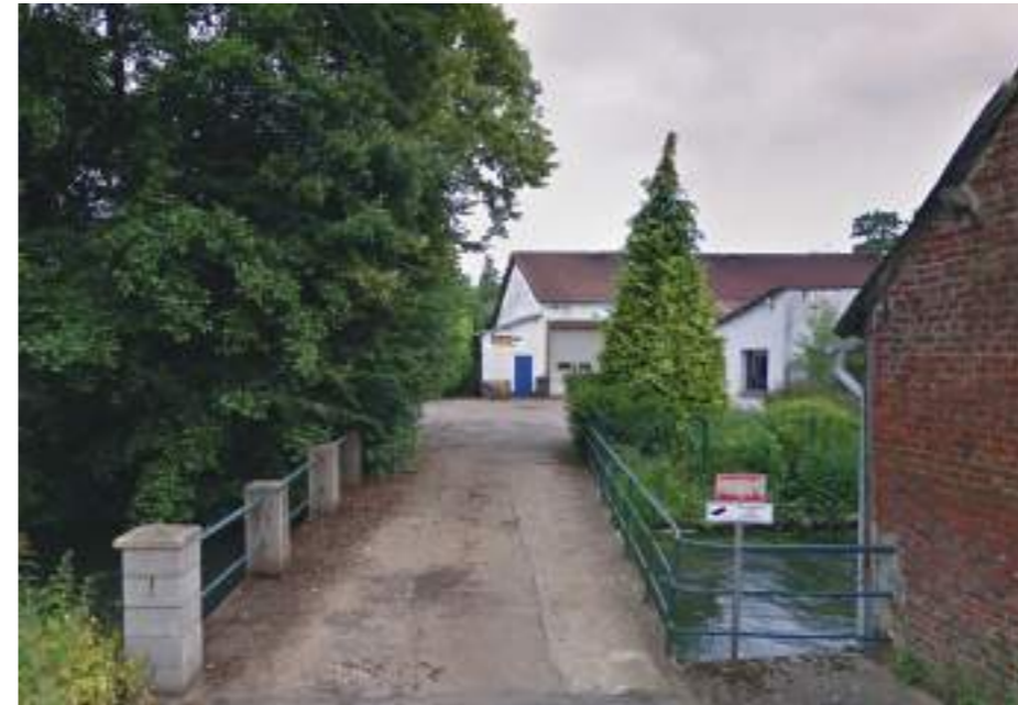
vue de l'entrée du site par le pont de la rue du Village Huet
