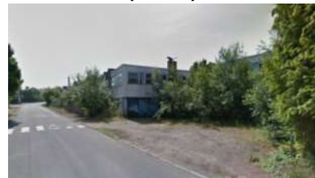
Partie de friche de l'usine Métra
