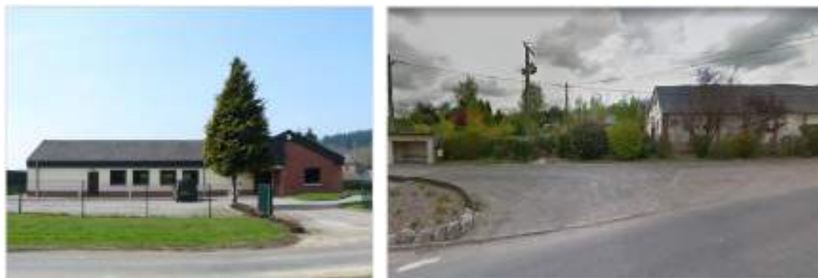
Stationnements dans le centre bourg
