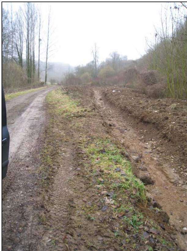
Fossé récemment réalisé le long du CR 20
