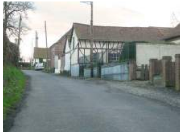
▲ FAITAGES PERPENDICULAIRES A LA VOIE RUE DE MAISNIERES
