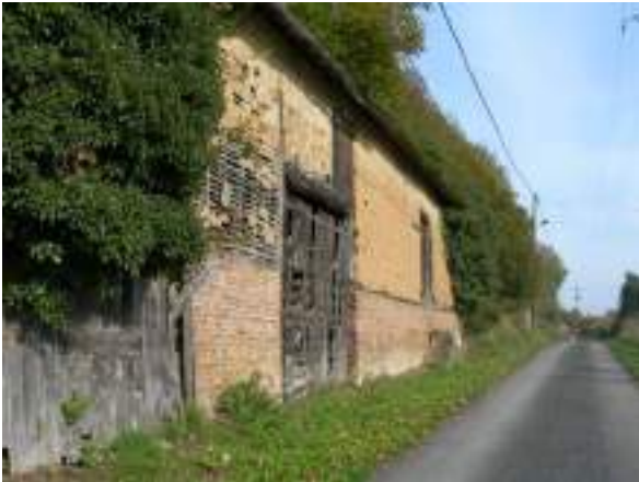
▲ FAITAGE PARALLELE A LA VOIE RUE DES AVERNES
