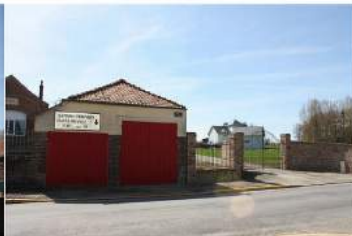
3 : Local des pompiers
