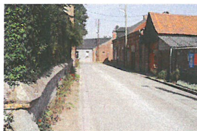
Le bâtiment des pompiers
