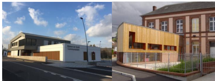
Maison de santé pluridisciplinaire de BLANGY-SUR-BRESLE (76) Crédit Photo : Espac'Urba/Alise Environnement
