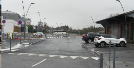
Pôle multimodal de BLANGY-SUR-BRESLE (76) Crédit Photo : Espac'Urba
