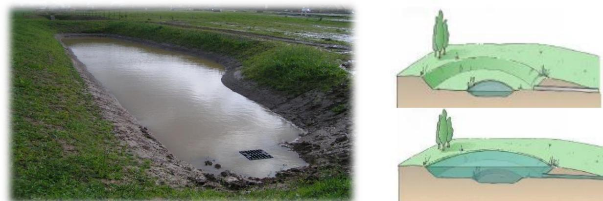
Le réaménagement des mares comprend généralement un reprofilage des berges, la mise en place de dispositifs de contrôle des ruissellements (débits de fuite et surverse) et peut être complété d'une végétation épuratrice et paysagée. Un panneau pédagogique sur le rôle épurateur des végétaux pourra être mis en place afin d'apporter une fonction pédagogique.
