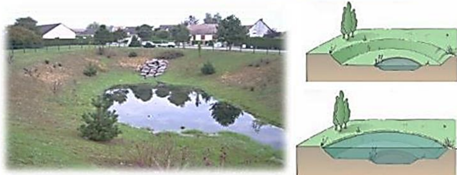
Mare fonctionnant par infiltration et trop plein
