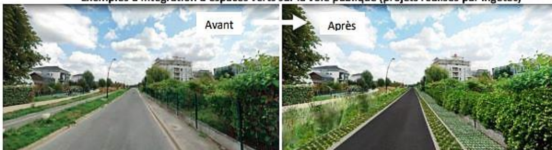
Opération de désimpermeabilisation sur la voie publique (trottoirs, chaussée)
