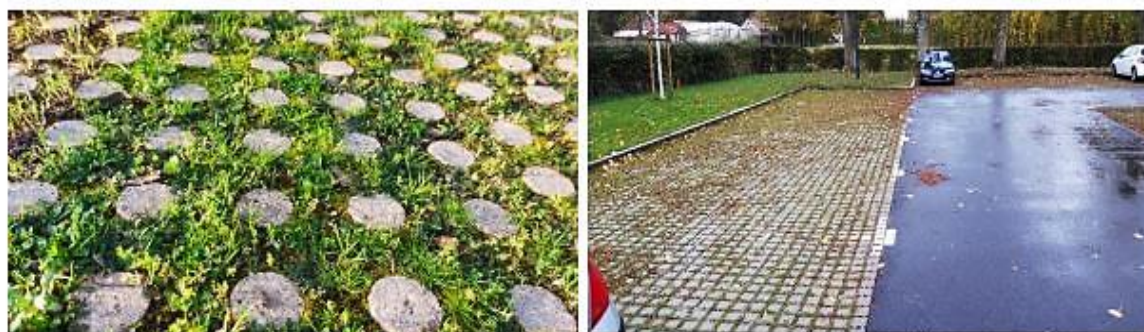
Réalisation d'un parking enherbé
