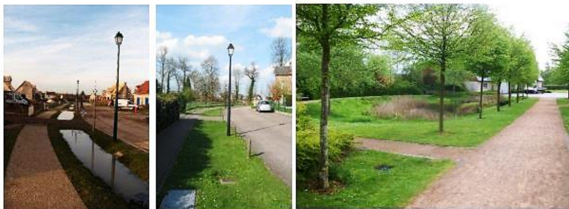
Aménagements de l'espace public : création de noues enherbées et de jardins de pluie
